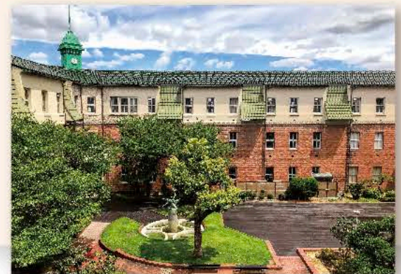
大阪市立工芸高等学校 本館 (大阪市指定有形文化財)
